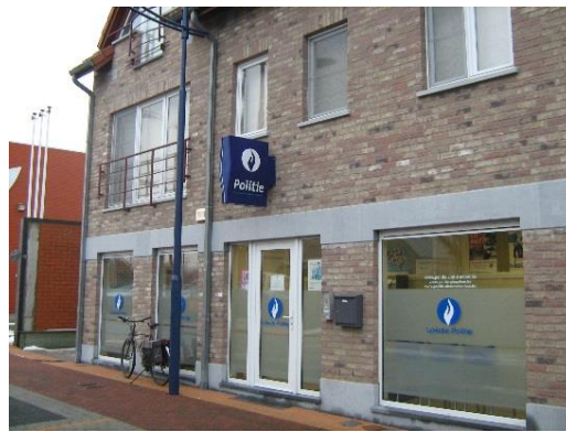
Politiepost Nieuwerkerken Nieuwesteenweg 3
